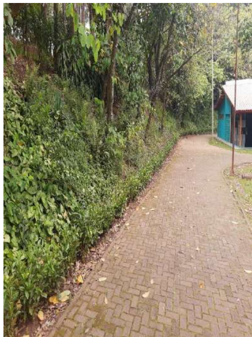
Figura 23 -Reforma de canteiro
