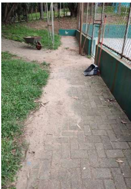
Figura 49 - Limpeza vias de acesso
